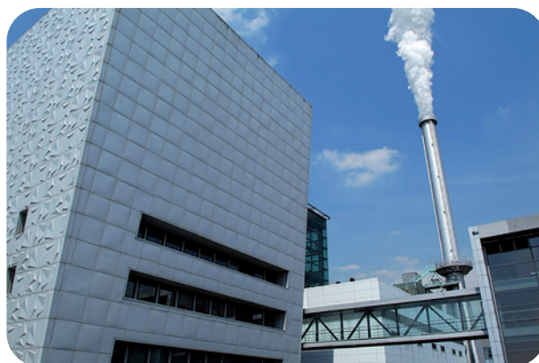
Centre d'incinération à Ivry/Paris XIII - SYCTOM
