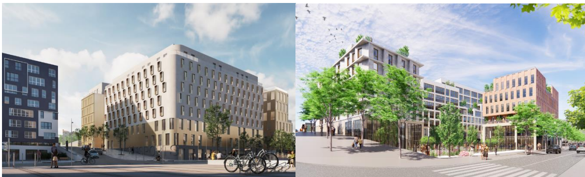
Evolutions du lot B3 entre 2020 et 2021 depuis l'angle entre le pont des Mariniers et l'avenue Louis Luc - Source : Brenac & Gonzalez, juin 2020 à gauche et décembre 2021 à droite
